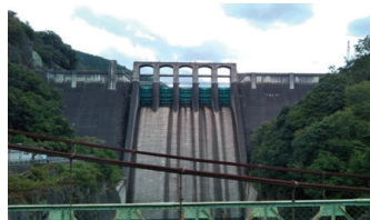
加茂郡八百津町と可児郡御嵩町に跨がる丸山ダム。現在、かさ上げによる再開発事業が進んでいる。
