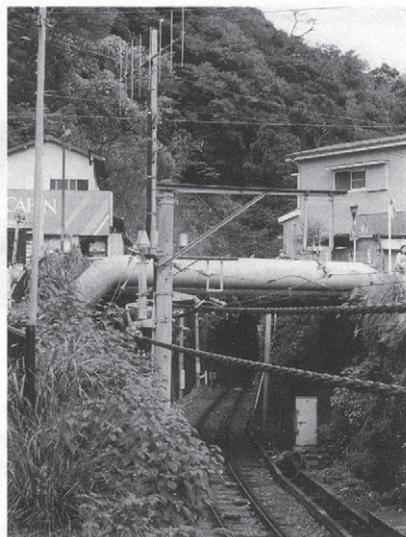
極楽寺駅側のトンネル入口に取付けられたアンテナは、LCXと電波をやりとりする窓口になっている。
