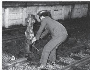
車庫から出庫するときに切替えるポイントが手動式。その切替えを行うのは江ノ島駅の職員だ。
