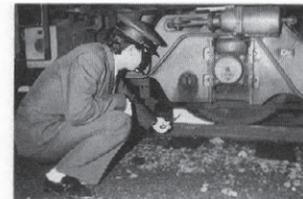
車庫の電車に付けられた車輪を動かさないようする「手歯止め」を外すことが、朝一番の作業だ。
