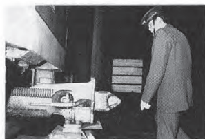
電車を連結する連結器部分も、重要な点検項目だ。
