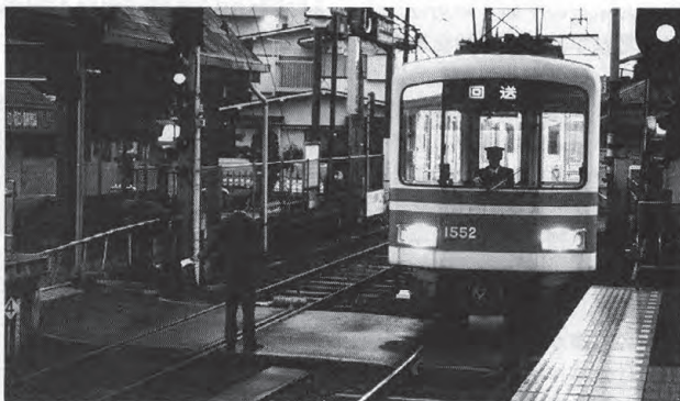
車庫から出庫する電車は、直接下り線ホームへ出られない。そこで、いったん藤沢方面へ向かい、そこから下り線ホームへ横付けされる。
